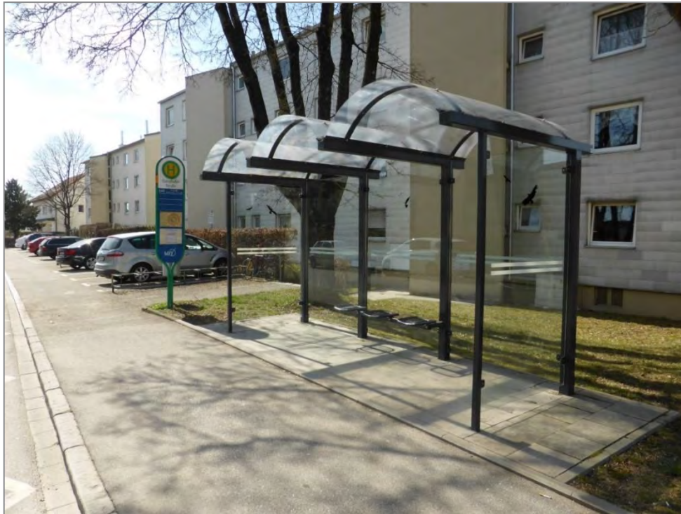
Abbildung 76 - Bushaltestelle Ganghoferstraße (Eigenes Foto)
