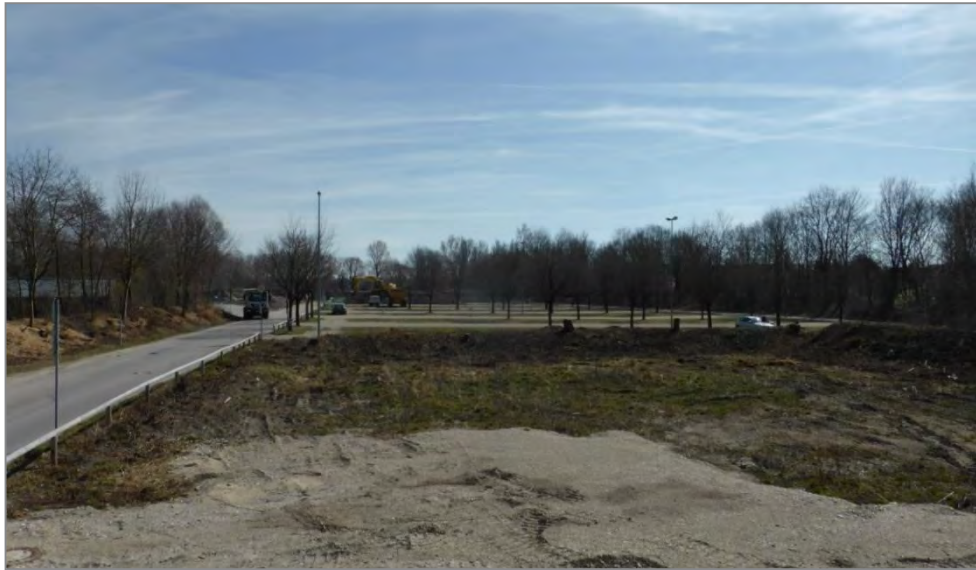
Abbildung 75 - Parkplatz am Kronthaler Weiher während der Erweiterungsarbeiten (Eigenes Foto)
