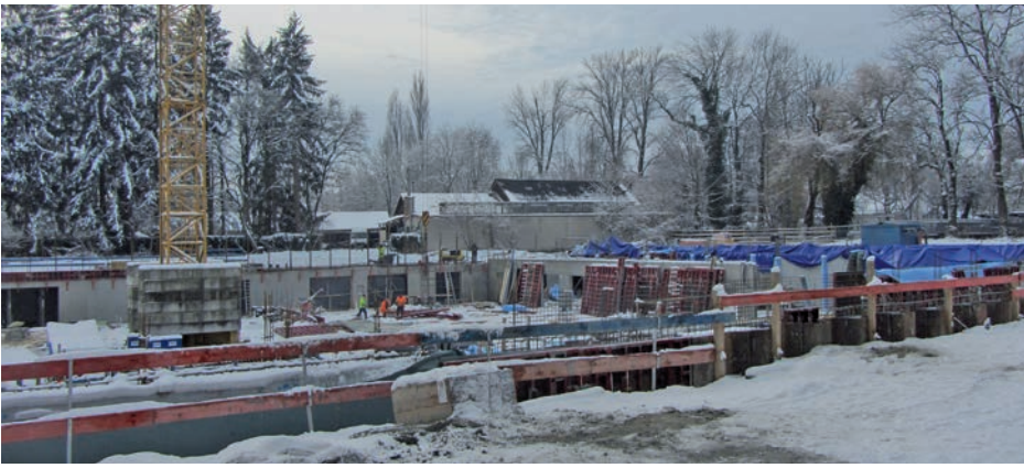
Die Baustelle am Lodererplatz ist aktuell die größte im Stadtgebiet.
