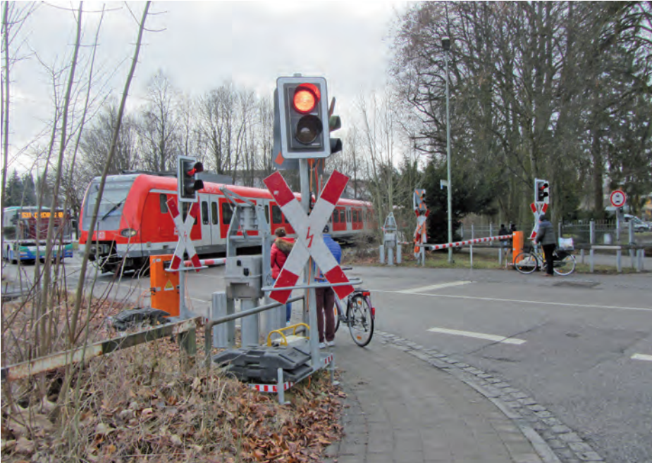
Ab 1. Februar ist der Bahnübergang in der Haager Straße für Autos, Fußgänger und Radfahrer nicht mehr passierbar. Sanierungsarbeiten der Bahn an der Schrankenanlage verzögern sich.
