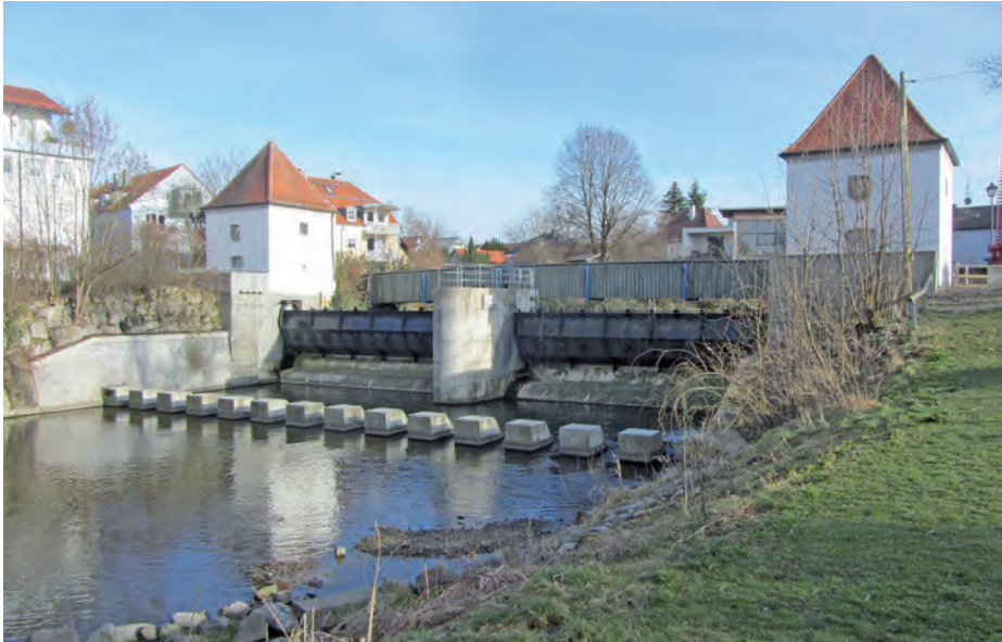
Das Stadtwehr schützt das Stadtgebiet in erster Linie vor Hochwasser.
