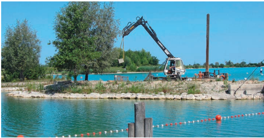
Eine Baggerschute ist derzeit an der Insel im Einsatz.
